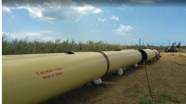
外喷聚氨酯内自锚铸管用于特力尼达与多巴哥工程 Inner self-anchored ductile iron pipes coated external PU used to Trinidad and Tobago project (口径: DN1000mm 工作压力: 2.0Mpa 长度: 40km)
